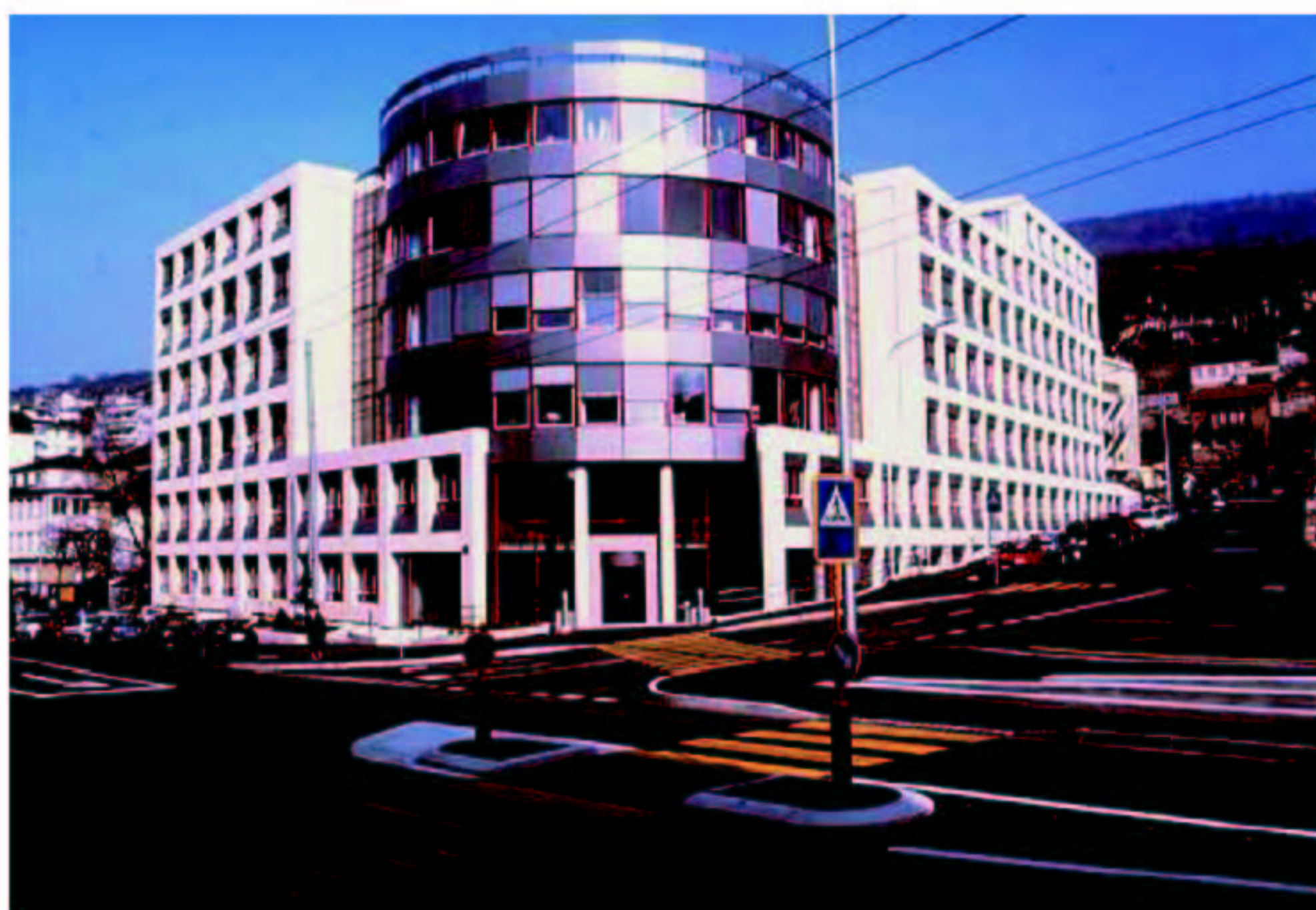
Bâtiments du CSEM à Neuchâtel
