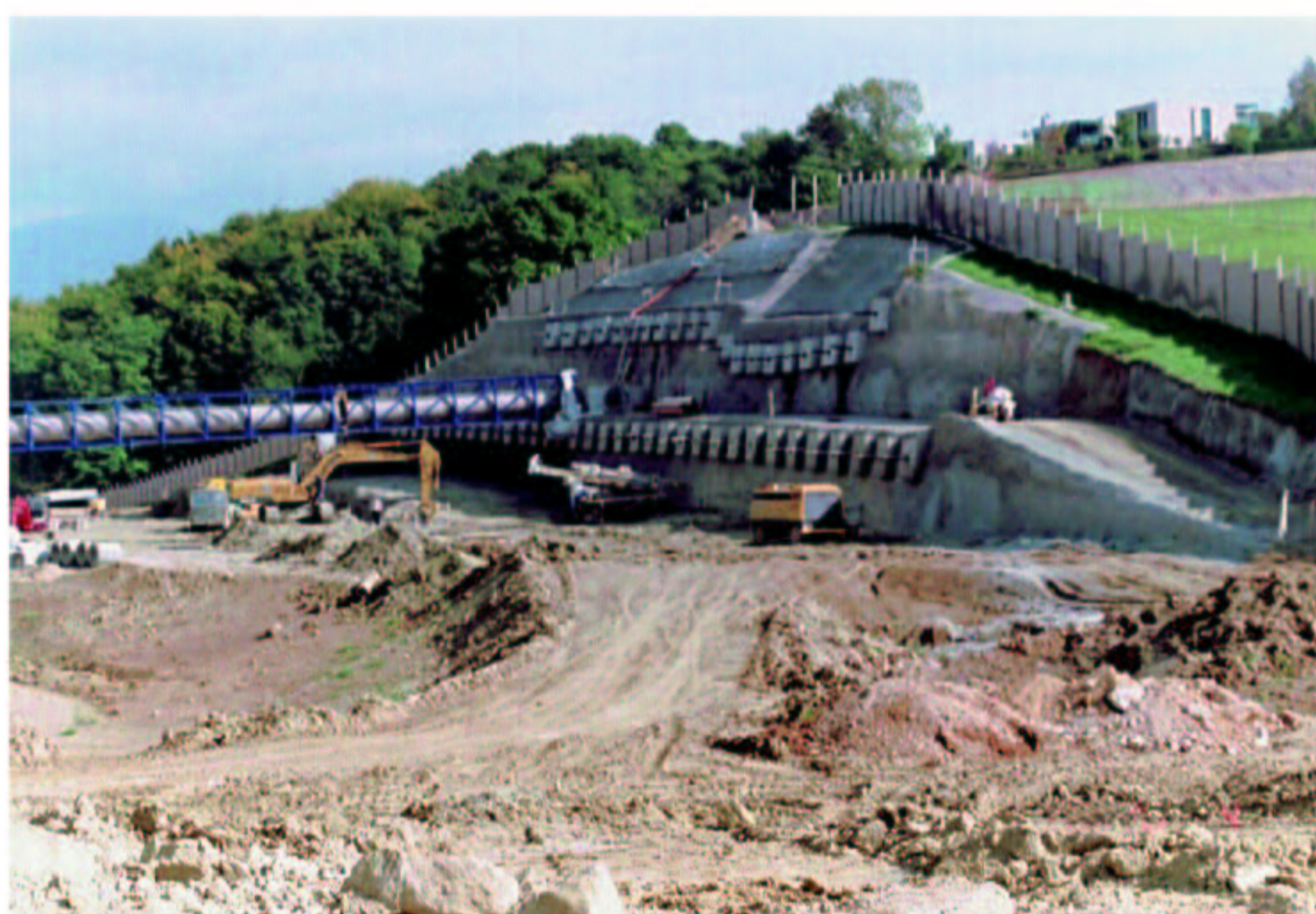
Tranchée couverte de Chanélaz à Boudry
