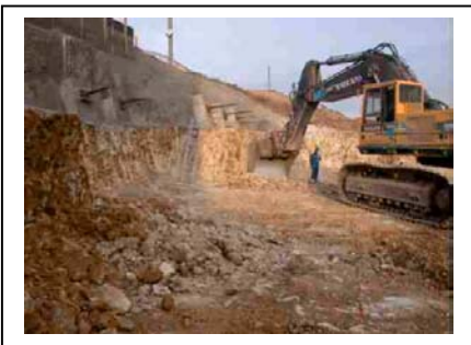
Suite de l'excavation mi décembre 2003
