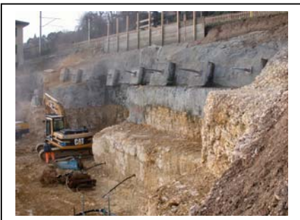
2 e rangée d'ancrages janvier 2004
