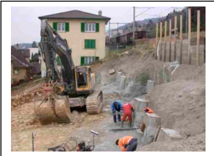
1 e rangée d'ancrages fin novembre 2003
